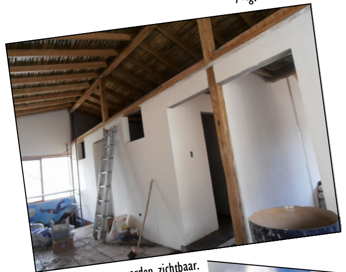
Verbouwingen in het gastenhuis: eern nieuwe verdieping.
